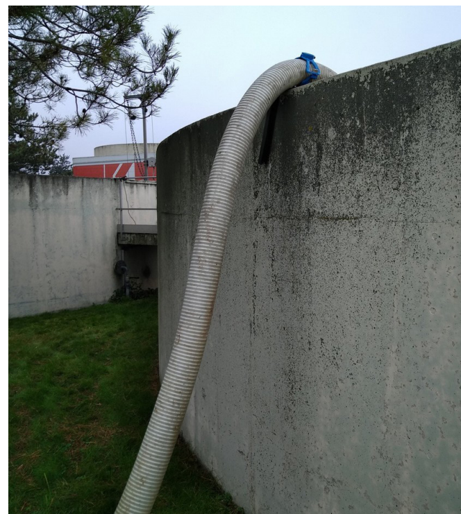
Les boues arrivent à la station par la rotation de camions citernes et sont stockées provisoirement dans un silo (Crédit photo CCSSOM)
